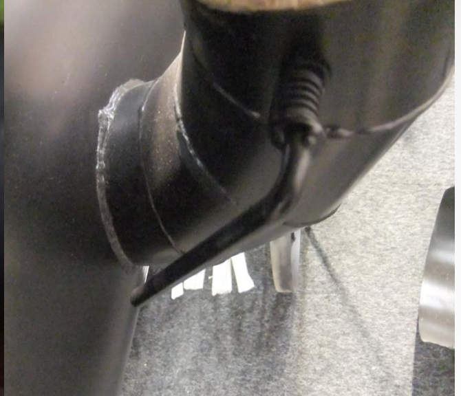
Hormin vetopellin säätö
